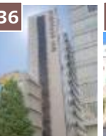
36 くれたけインプレミアム名古屋納屋橋
