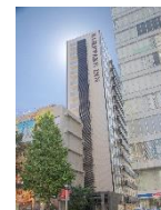
くれたけインプレミアム名古屋納屋橋
