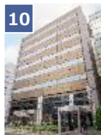
10 MIテラス仙台広瀬通り
