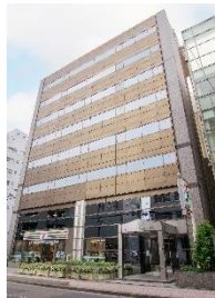
MI テラス仙台広瀬通り（一部専有部及び共用部） （報告期間内実施）
