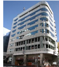
MI テラス北上野（一部専有部及び非常用照明） （報告期間内実施）
