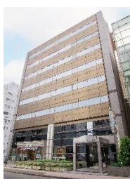
MI テラス 仙台広瀬通り
